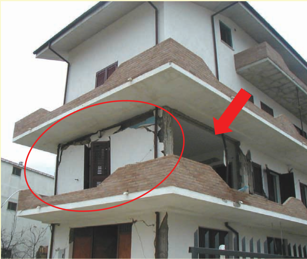
Tamponamenti “a cassetta” ribaltate
