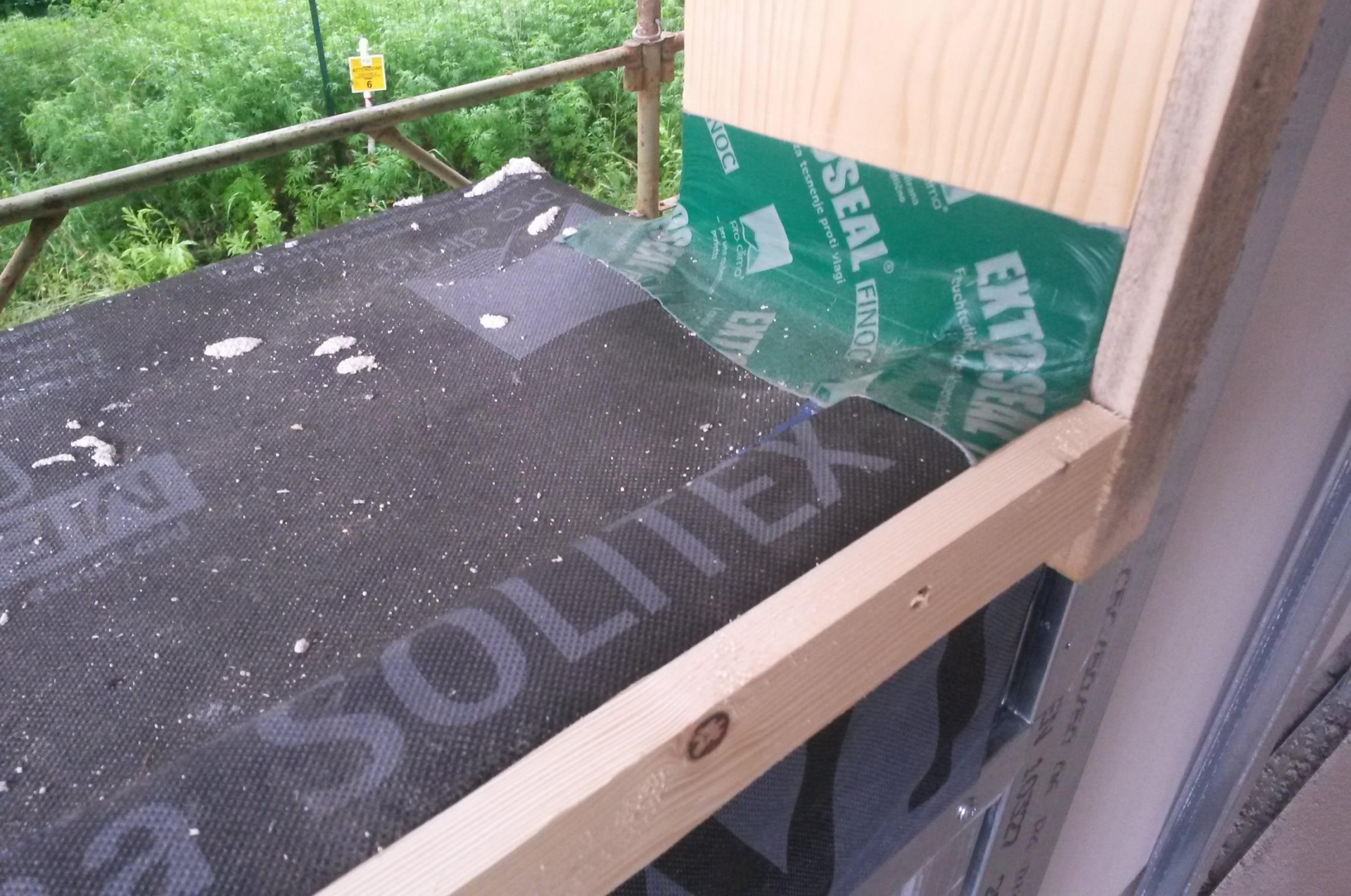
Scuola Italo Calvino (FI): foro serramento
